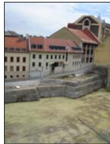
Baustelle - oder archäol. Grabung? - Hier oft ident.
